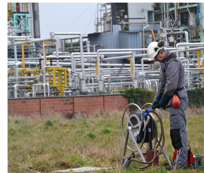
Absaugvorrichtung an einer Bohrung
